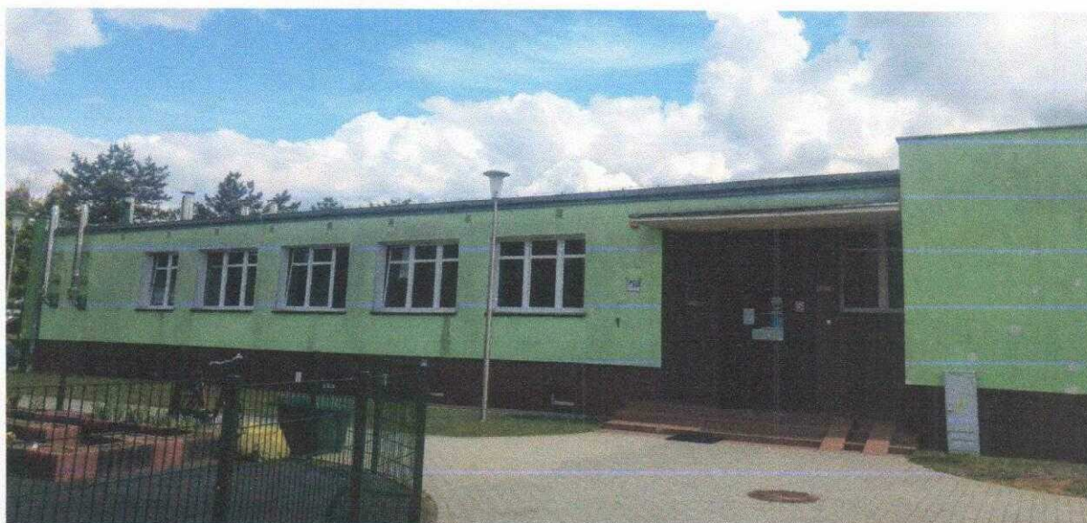
Zdjęcie 2: Budynek Internatu Specjalnego Ośrodka Szkolno-Wychowawczego w Pile, materiał własny.
